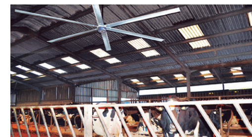
多くの酪農家の願いに応えたHVLSファン。日本国内でも牛舎への導入が始まっている
